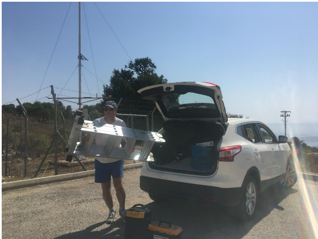
Εικόνα 1.2-9: Απο τις τεχνικές εργασίες στον σταθμό ΚΕΦ-3 στις 28/8/2022.
