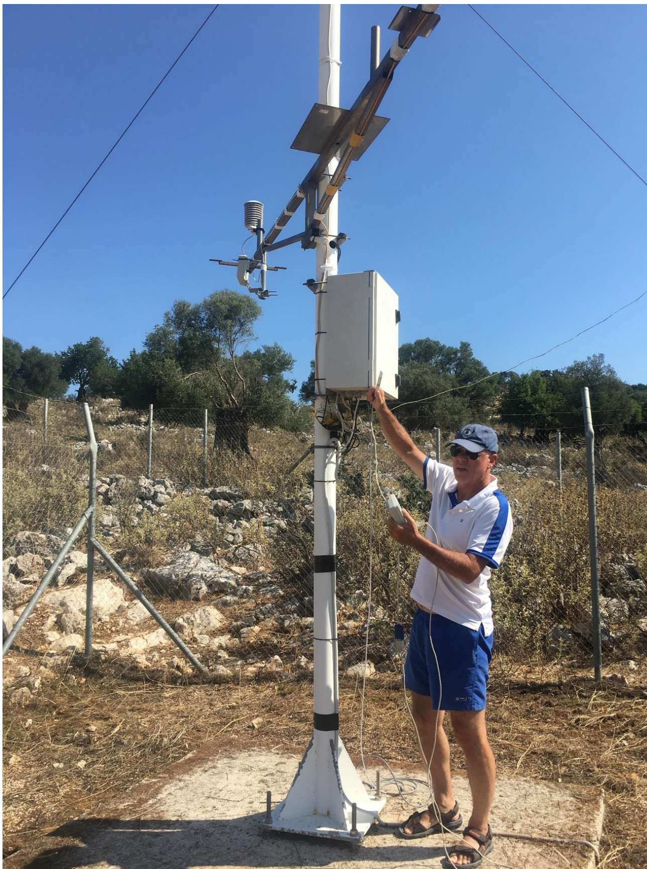
Εικόνα 1.2-16: Απο τις τεχνικές εργασίες στον σταθμό ΚΕΦ-3 στις 29/8/2022.
