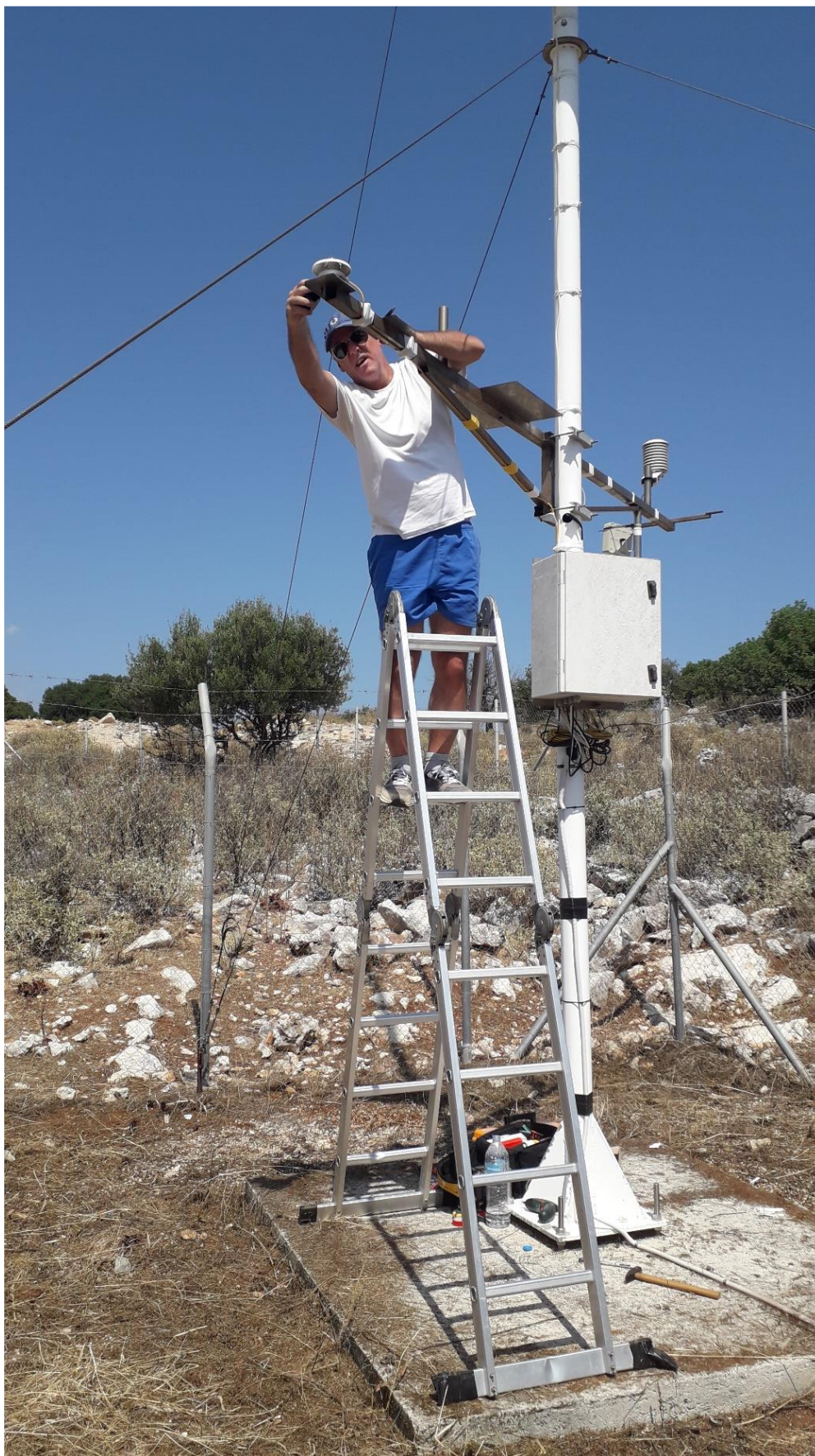
Εικόνα 1.2-14: Απο τις τεχνικές εργασίες στον σταθμό ΚΕΦ-3 στις 28/8/2022.
