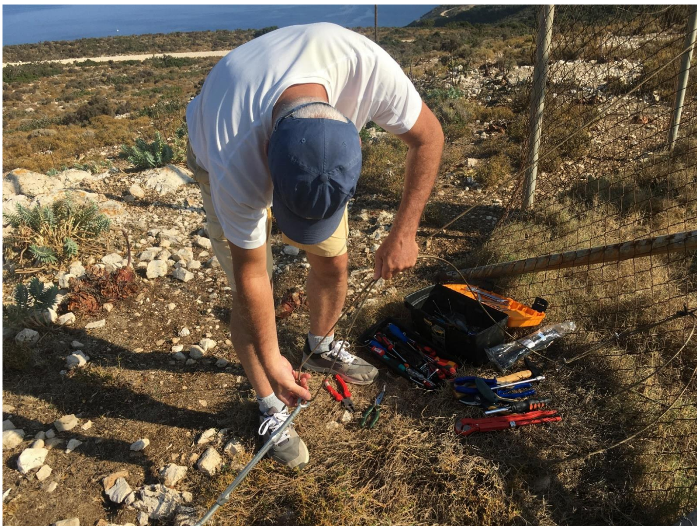
Εικόνα 1.2-3: Απο τις τεχνικές εργασίες στον σταθμό ΚΕΦ-2 στις 26/8/2022.
