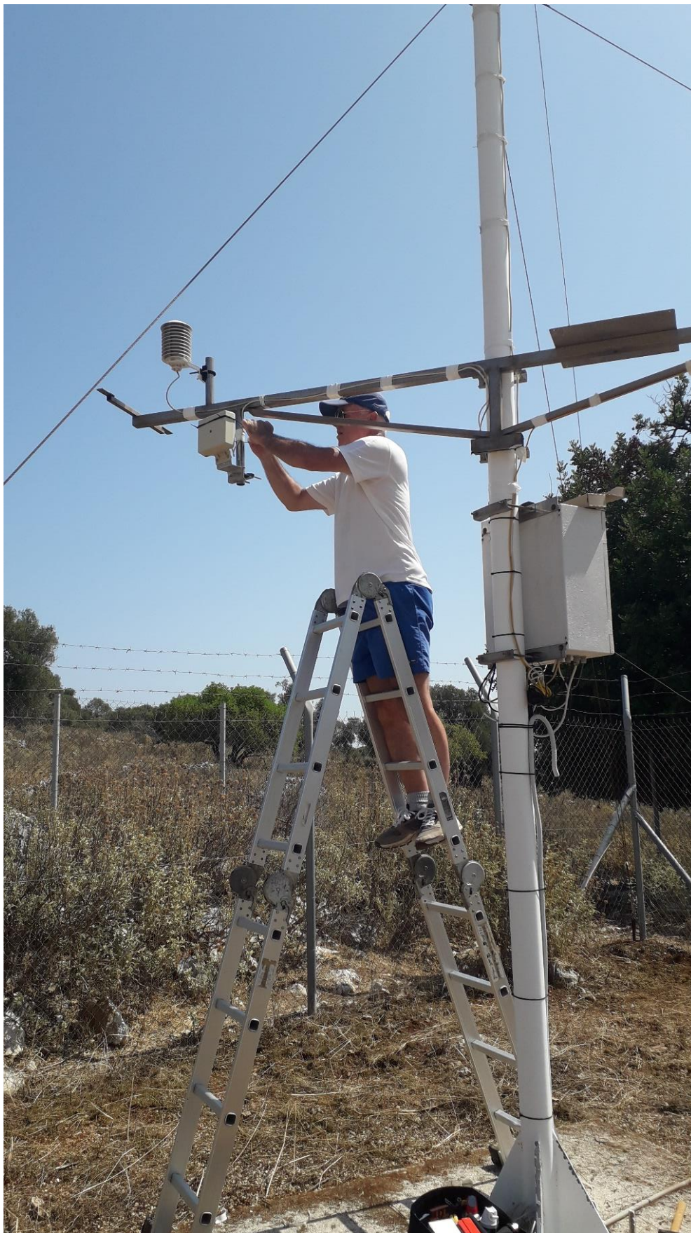
Εικόνα 1.2-13: Απο τις τεχνικές εργασίες στον σταθμό ΚΕΦ-3 στις 28/8/2022.
