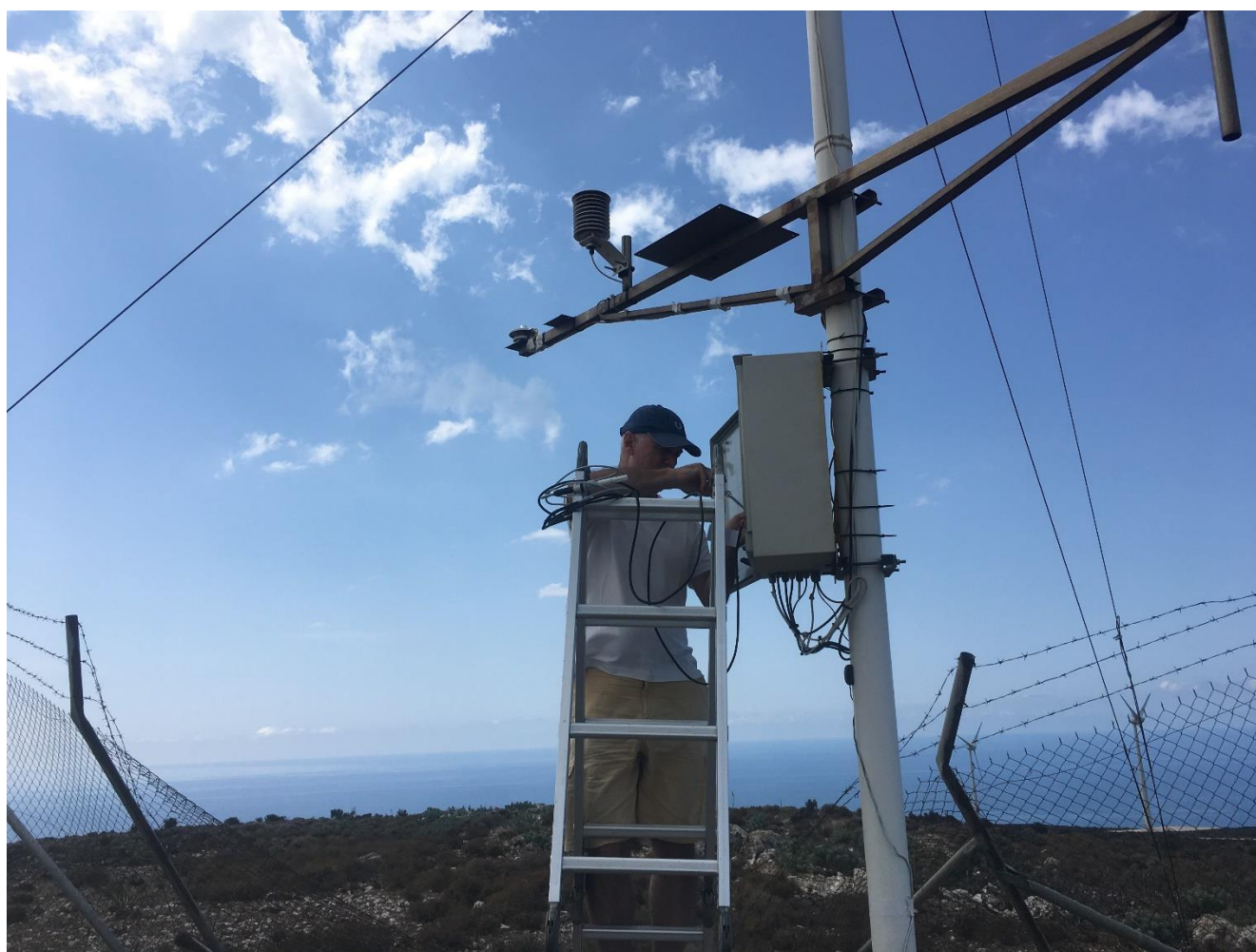
Εικόνα 1.2-4: Απο τις τεχνικές εργασίες στον σταθμό ΚΕΦ-2 στις 26/8/2022.
